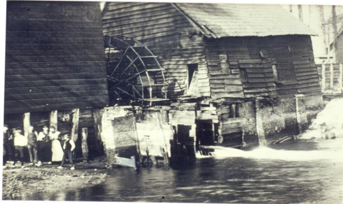
Figuur 4. De dubbele watermolen op het Smalwater (Molengraaf) te Boxtel in 1910. Rechts de oliemolen. In het linkerdeel bevond zich zowel een volmolen als een graanmolen.
