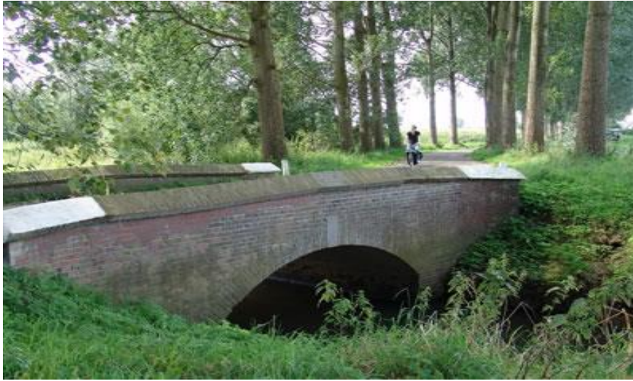
Figuur 6. Zicht op de brug over de Grootte Waterloop in de Meulekensweg te Liempde. Nabij deze brug moet de Antselse watermolen gelegen hebben. (Foto: Brabants Centrum, Marc Cleutjens)
