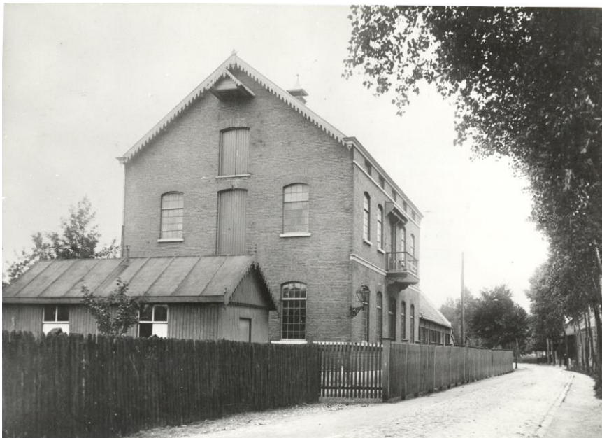
Linnen- en damastweverij Van Hoogerwou fabriceerde tot 1905 uitsluitend handgeweven producten. In 1905 kocht Van Hoogerwou het eerste machinale getouw, aangedreven door een elektromotor. 11 Deze foto van het hoofdgebouw, opgetrokken in 1867, dateert van ongeveer 1900. In de nok van de zijgevel de katrol, waarmee de gebleekte en gewassen stukken naar de droogzolder werden gehesen.
