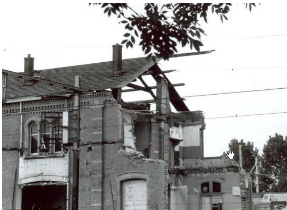
Sloop van station Boxtel, 1998, Collectie Heemkundekring Boxtel
