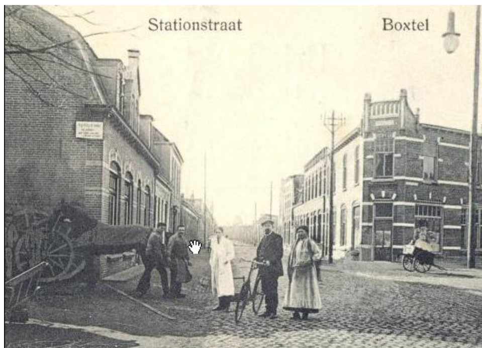
Stationsstraat Boxtel, Collectie Heemkundekring Boxtel
